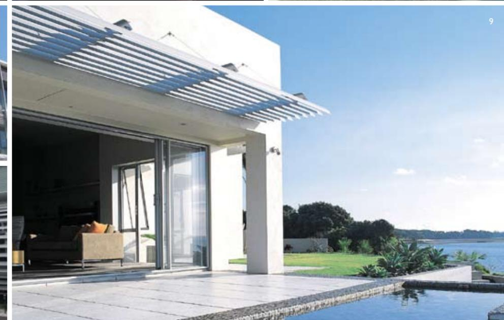
1+2 // 200MM VERTICAL PANELS    3 // 180 OVERHEAD 'EYEBROWS'    4 // 90MM MINI-LOUVRES    5 // 200MM OVERHEAD SHADING
