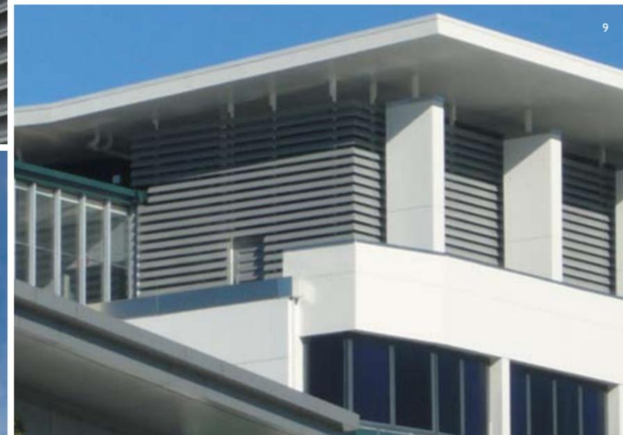
1 // 300MMX50MM BOX LOUVRES    2 // 120MM CAR PARK VENTILATION    3 // 120MM AIRFOIL VENTS    4 // 65MMX25MM BOX LOUVRES
